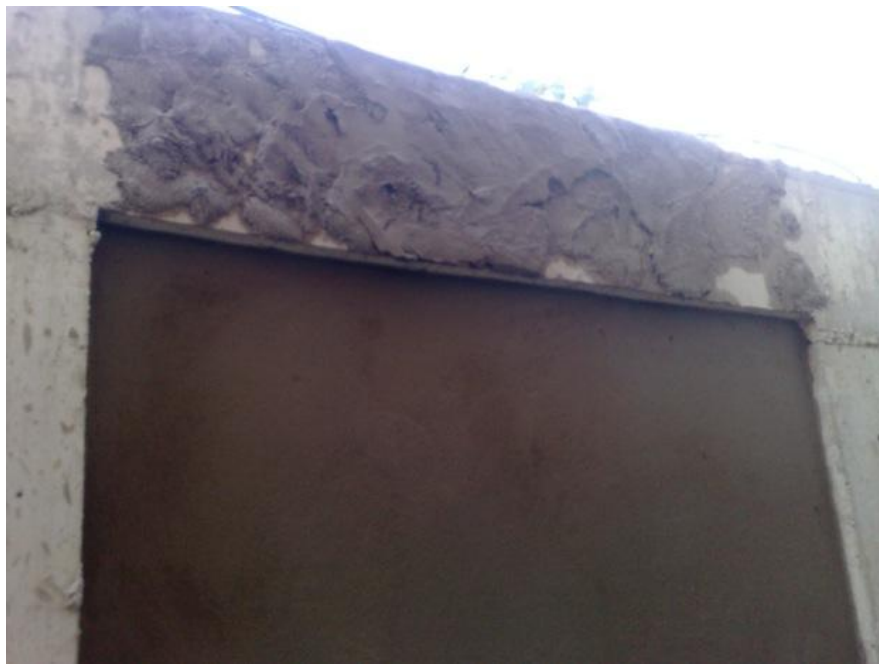
Figura 4.5– Revestimento com aplicação de solução de cal em substituição do chapisco.
