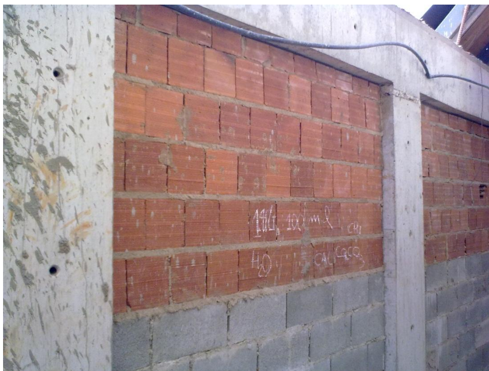
Figura 3.5 – Base utilizada para aplicação do revestimento
