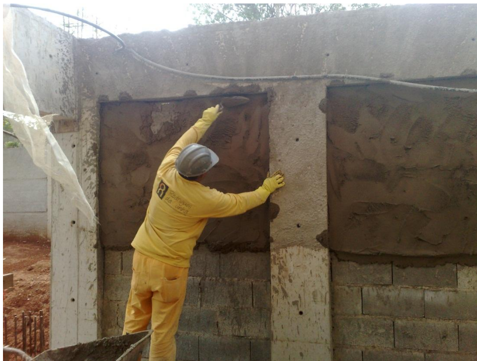
Figura 3.2 – Pedreiro executando o revestimento de argamassa nos painéis
