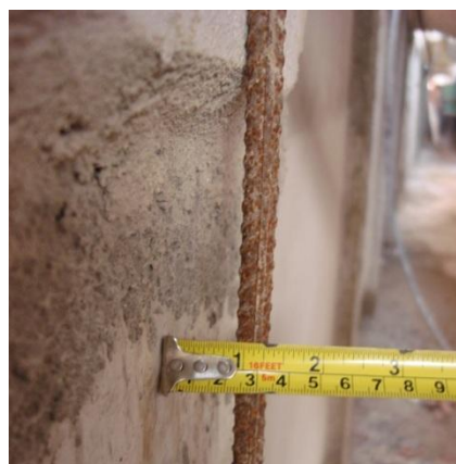
Figura 3.10 – Verificação da espessura do revestimento.
