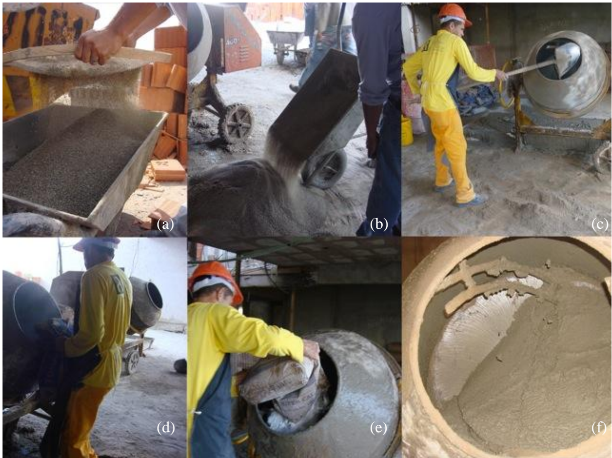
Figura 3.9 – (a) Peneiramento do resíduo; (b) Medida do resíduo para aplicação no traço; (c) Lançamento dos materiais na betoneira; (d) Lançamento do cimento na betoneira; (e) Lançamento da cal na betoneira; (f) Argamassa em fase final de mistura.
