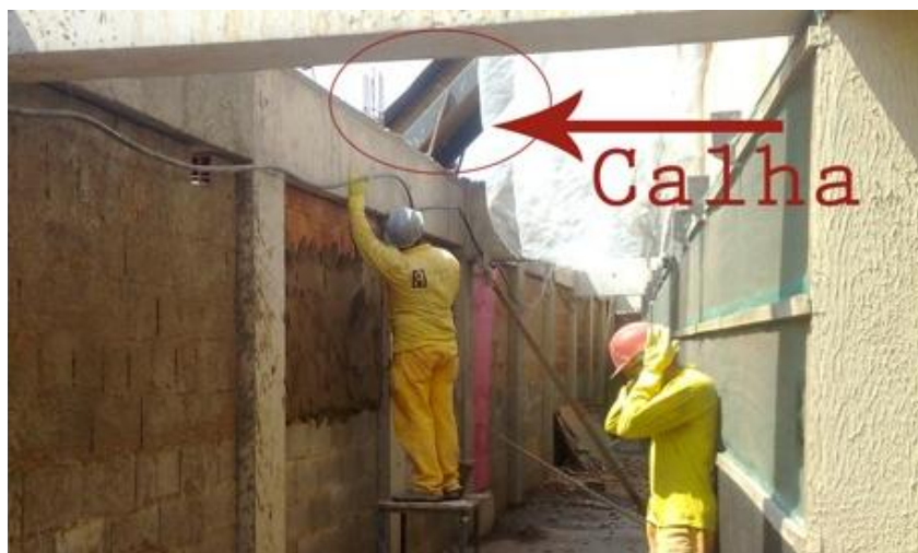
Figura 3.6 – Momento de aplicação de revestimento sobre a solução de cal e localização da calha de entulhos.
