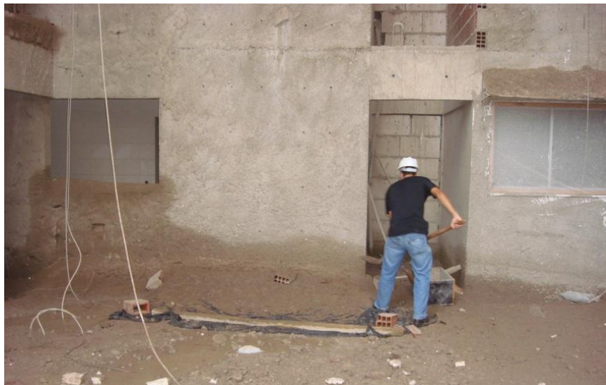
Figura 3.14 – Coleta do resíduo gerado na execução de reboco externo de argamassa
