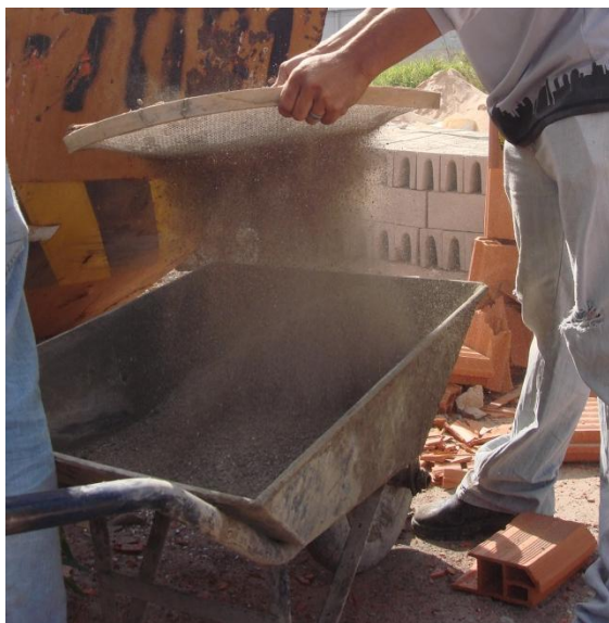
Figura 3.3 – Peneiramento do resíduo para preparação do traço com reaproveitamento de argamassa.
