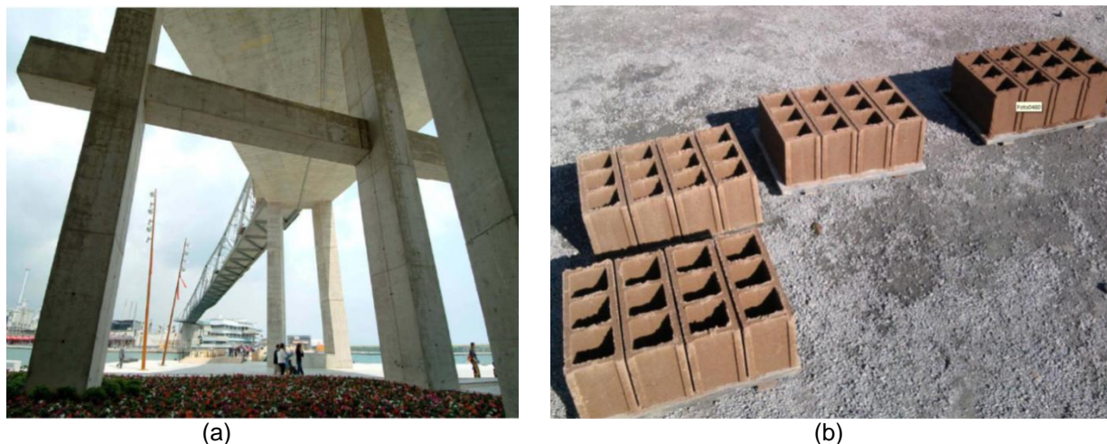
Figura 4 – Concreto estrutural com 20% de agregado reciclado de concreto (VAZQUEZ, 2008) (a) e bloco pré-moldado de concreto com 100% agregado reciclado misto (b).
