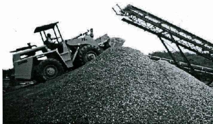
FIGURA 3.5 – Coleta do material britado proveniente da peneira de 1½ polegada.
