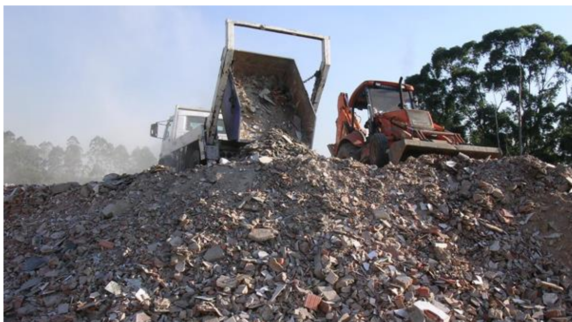
FIGURA 10: Descarregamento de RCC na URE (foto do autor)
