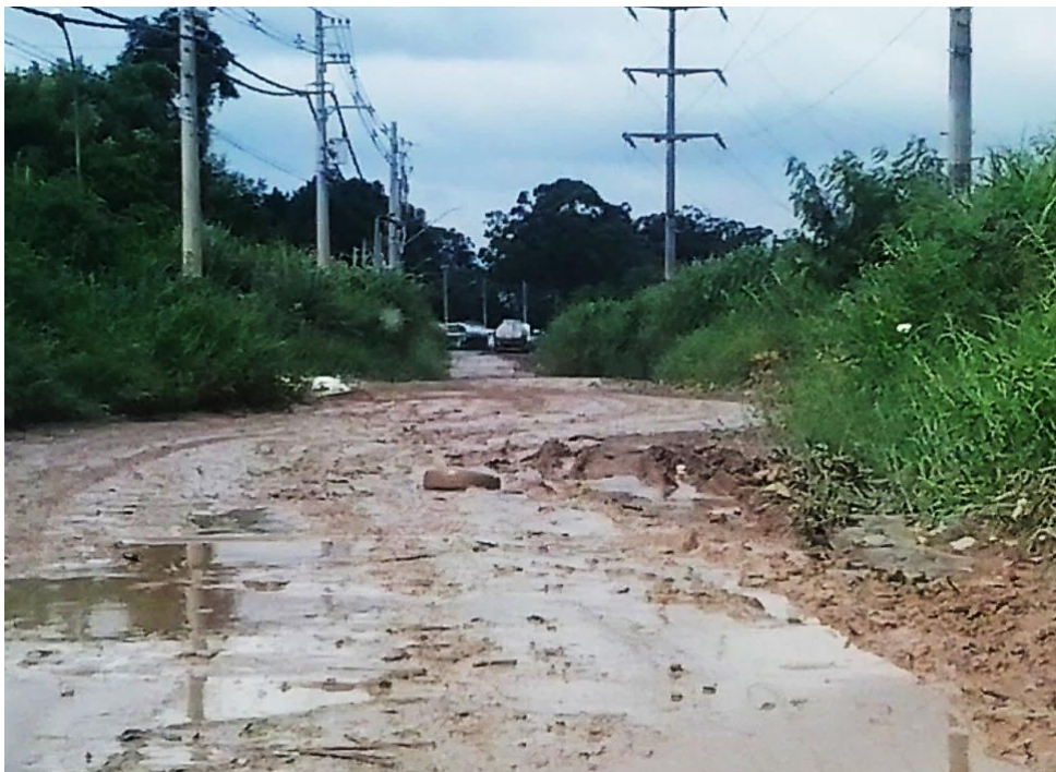
FIGURA 16: Condições existentes da Rua Orlando Bergamo – Cumbica, em fevereiro de 2014 (CORDEIRO, 2014).
