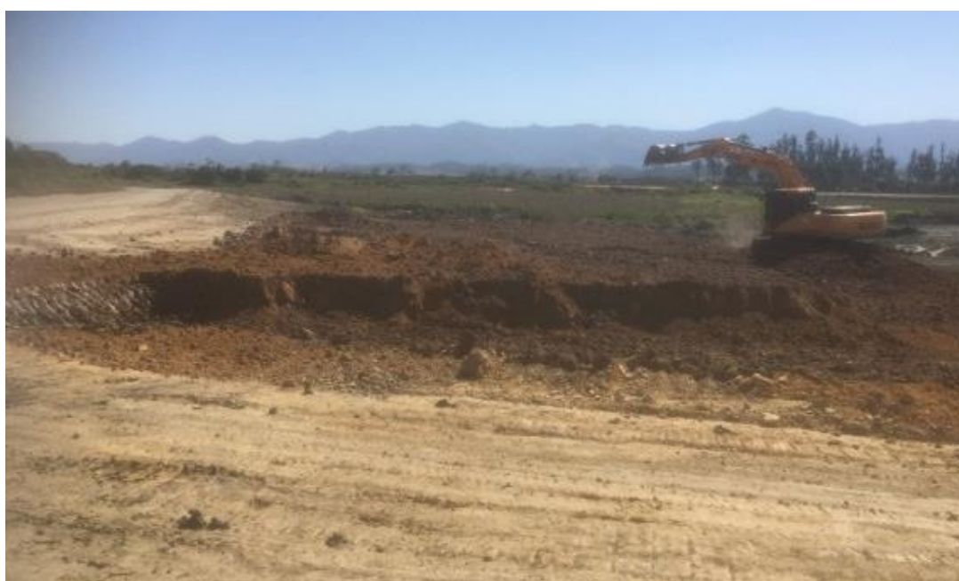
FIGURA 25: Escavação do talude (foto do autor)
