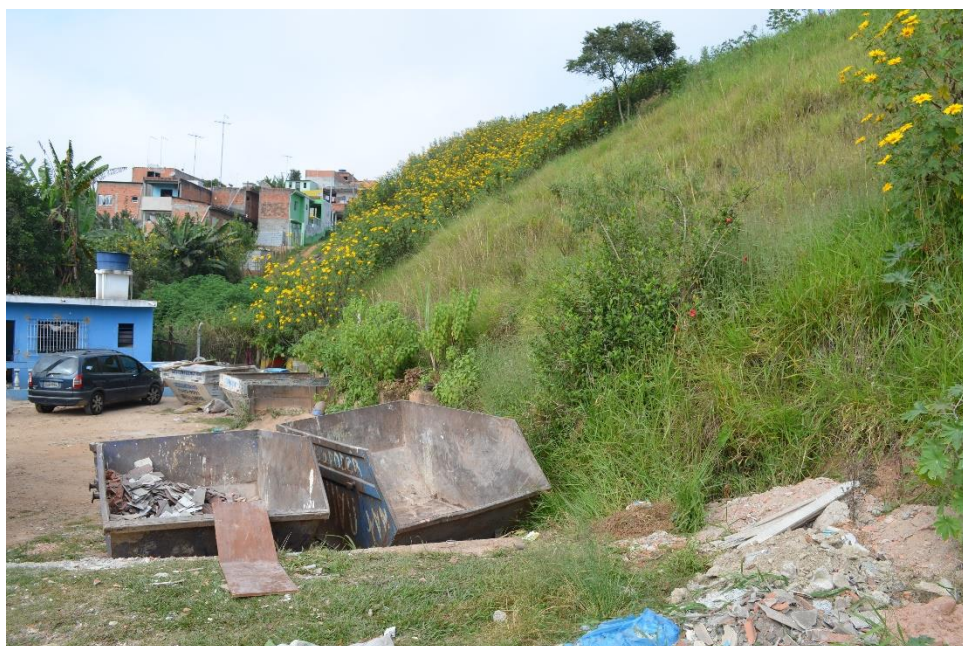
FIGURA 6: Área das caçambas Brooks e edificação de apoio do PEV Fortaleza. (foto do autor)
