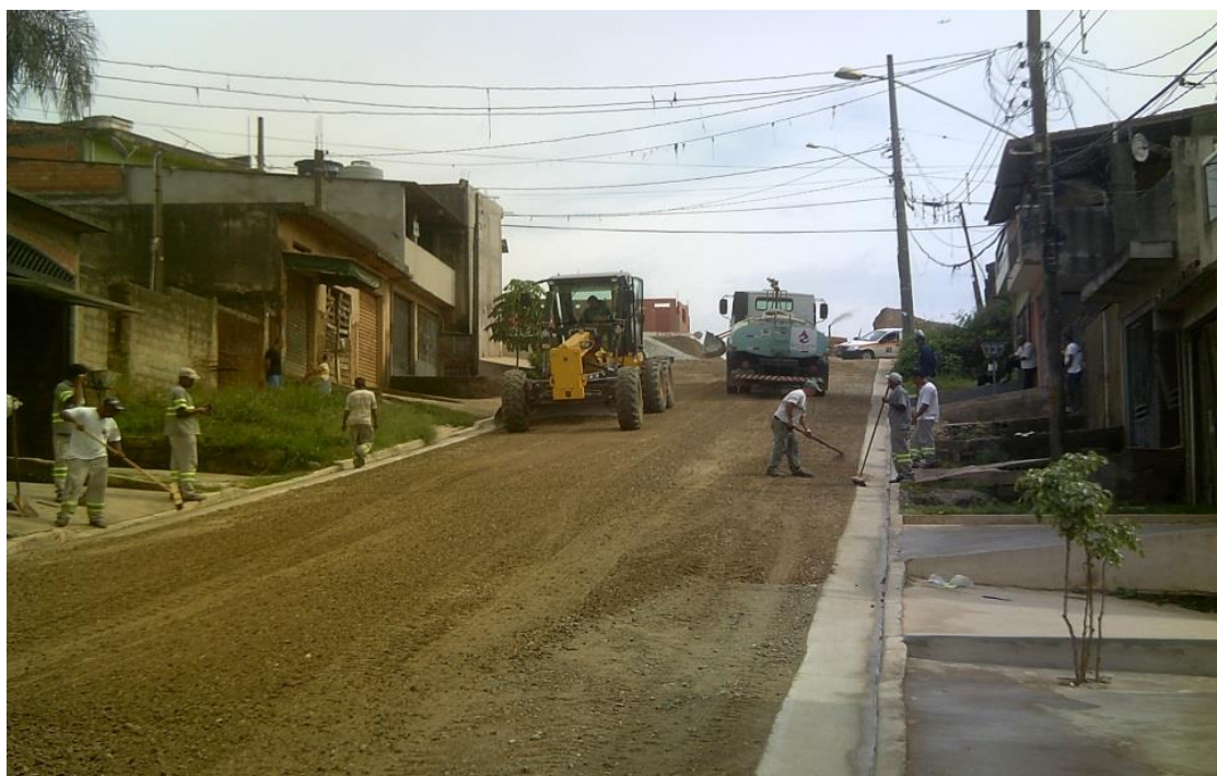
FIGURA 14: Rua Lagedão após a aplicação de Brita Graduada Simples e areia reciclada. (CORDEIRO, 2014).
