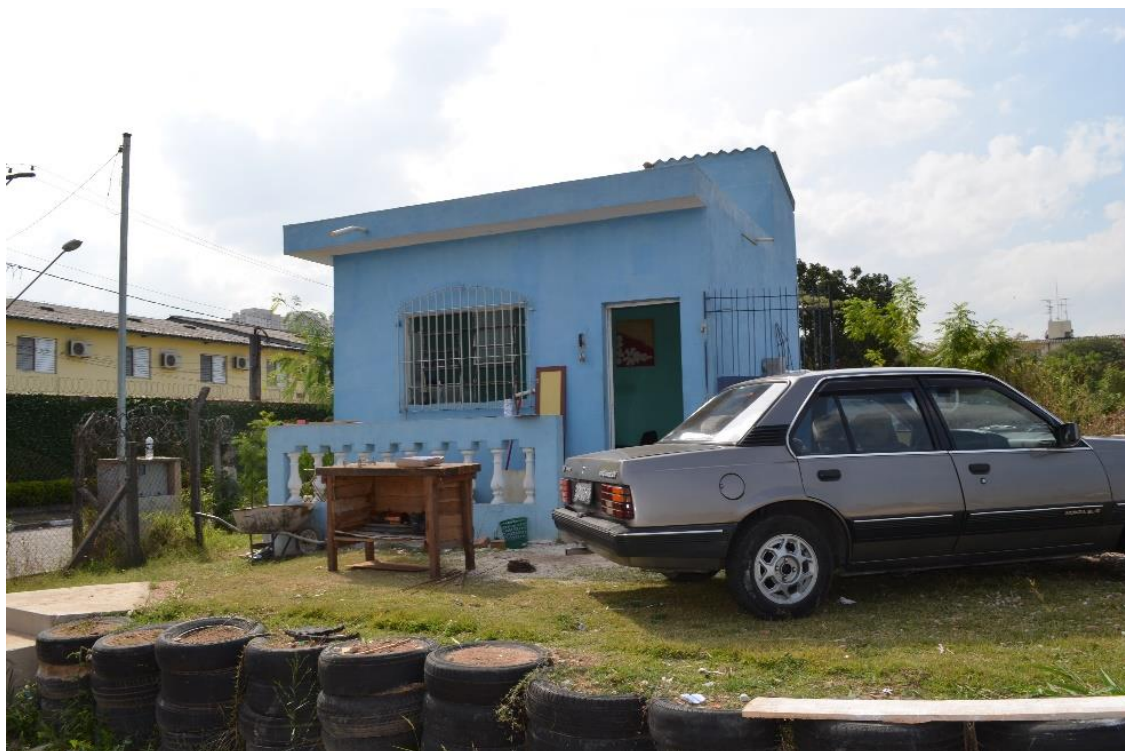
FIGURA 10: Edificação de apoio do PEV Ponte Grande (foto do autor)
