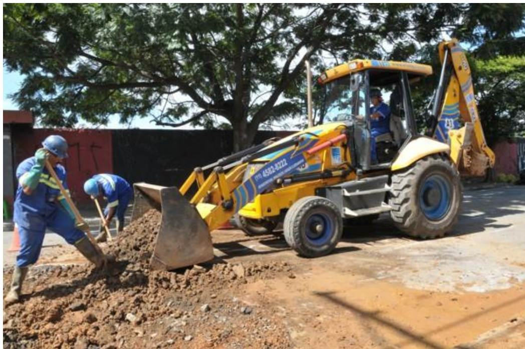
FIGURA 30: Utilização de agregado reciclado pelo SAAE (DOS ANJOS, et.al., 2013)
