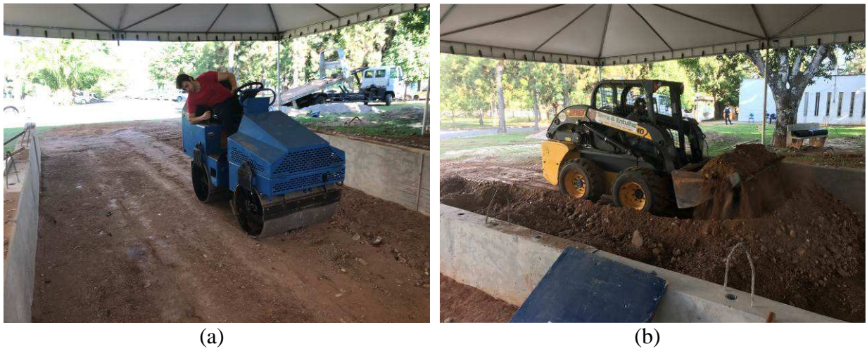
Figura 3.14 – Aferição da espessura da camada da base compactada.
