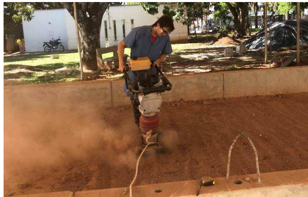
Figura 3.19 – Compactação com compactador a percussão.
