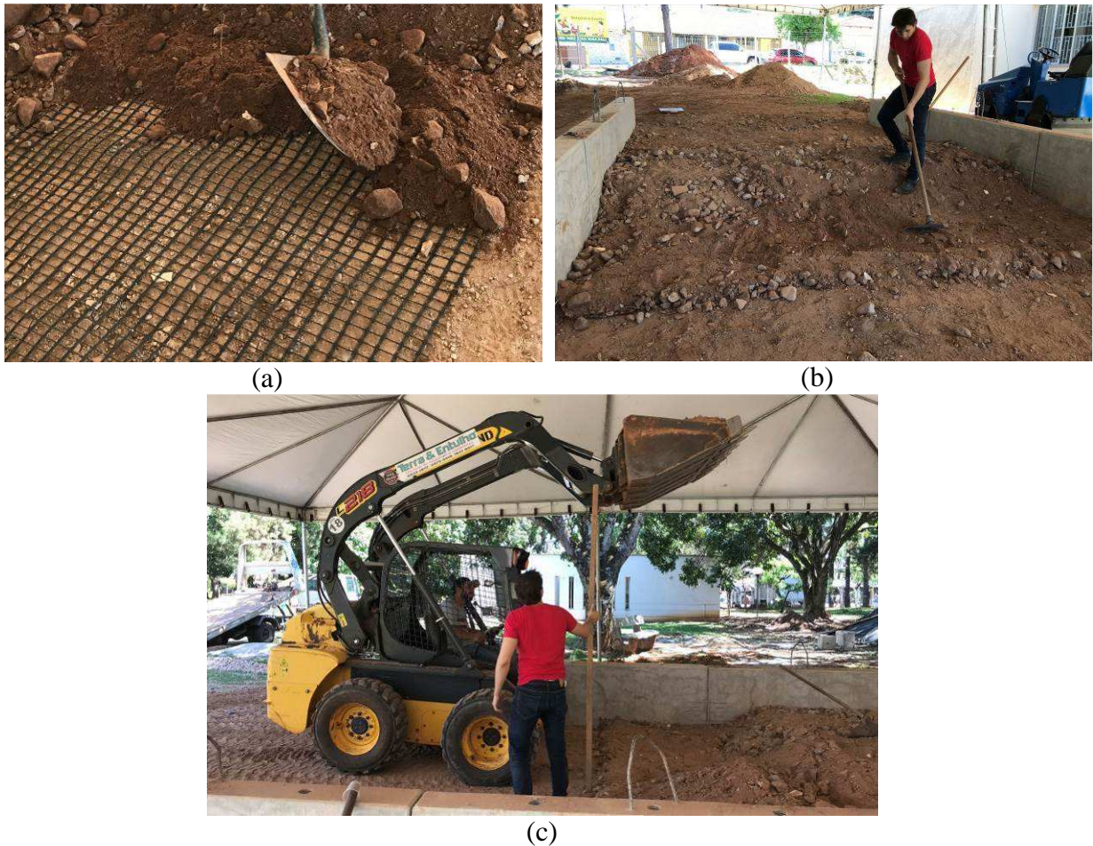
Figura 3.18 – Primeiro preenchimento da instalação experimental: (a) região destinada aos cenários sem compactação (SC) e com compactação com rolo vibratório (CR) e (b) compactação com rolo vibratório.
