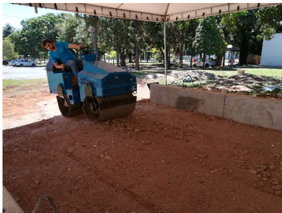
Figura 2. Compactação com rolo vibratório da camada RCD-R teste.
