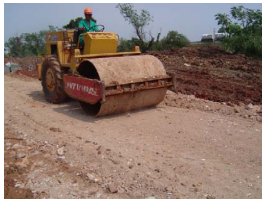
Figura 3.14: Compactação de camada de agregado reciclado
