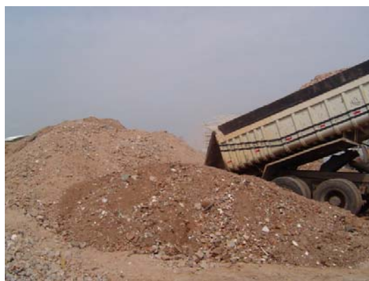
(b) Em obra de pavimentação
