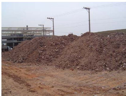
Figura 3.12: Pilha de agregado reciclado armazenada na obra
