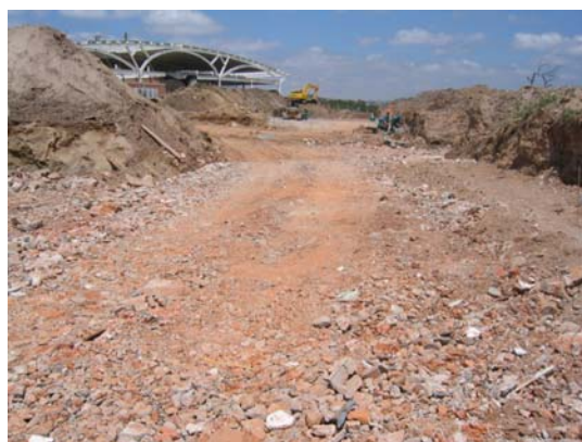
Figura 3.11: Camada de "rachão de entulho" após compactação
