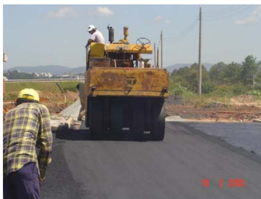
Figura 3.5: Compactação do revestimento asfáltico
