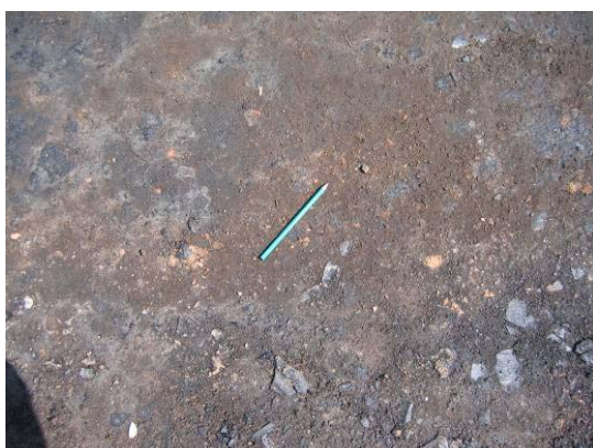
Figura 3.6: Base de agregado reciclado com imprimação impermeabilizante
