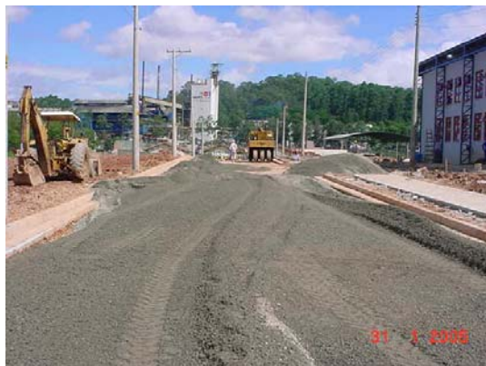
Figura 3.8: Camada de base de brita graduada simples sendo executada
