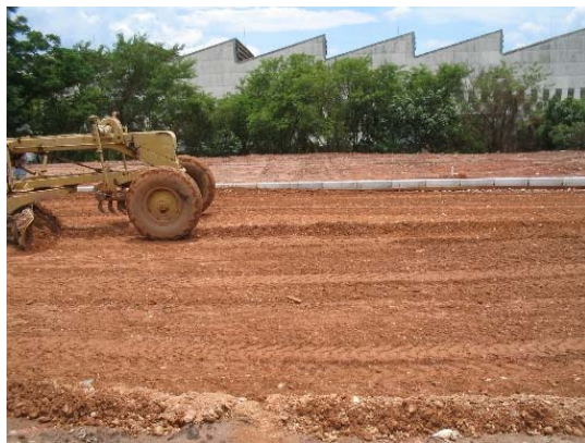
Figura 3.13: Motoniveladora espalhando a camada de agregado reciclado
