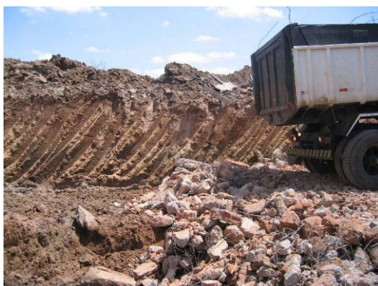
Figura 3.10: "Rachão de entulho" colocado sobre solo mole do subleito do sistema viário da USP Leste
