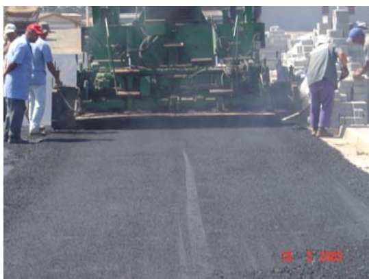
Figura 3.4: Vibroacabadora espalhando a mistura asfáltica
