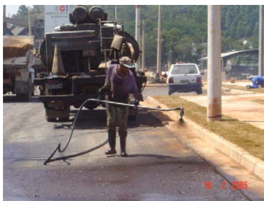
Figura 3.7: Execução da pintura de ligação sobre a camada de binder
