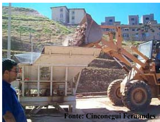
Figura 3.3: Lançamento de resíduo de construção no britador, em Belo Horizonte (MG) – foto retirada de Fernandes (2004)
