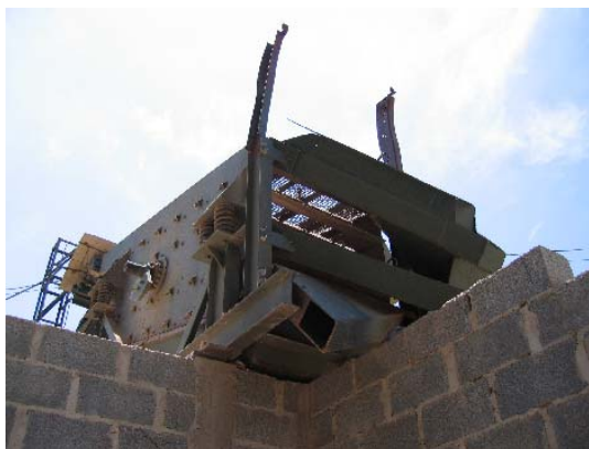
Figura 3.5: Vista inferior do peneirador, em Jundiaí (SP)
