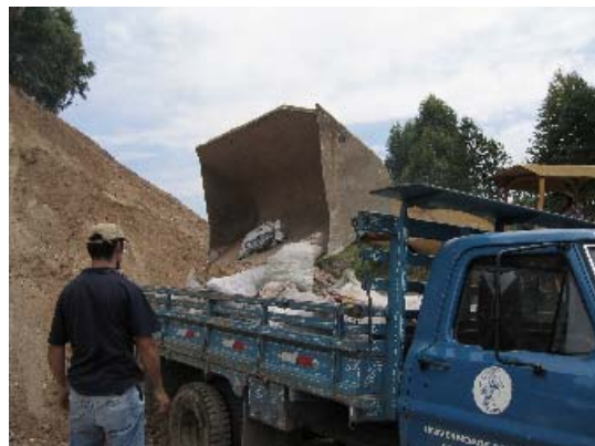
Figura 5.2: Disposição dos sacos no caminhão por meio de pá carregadeira
