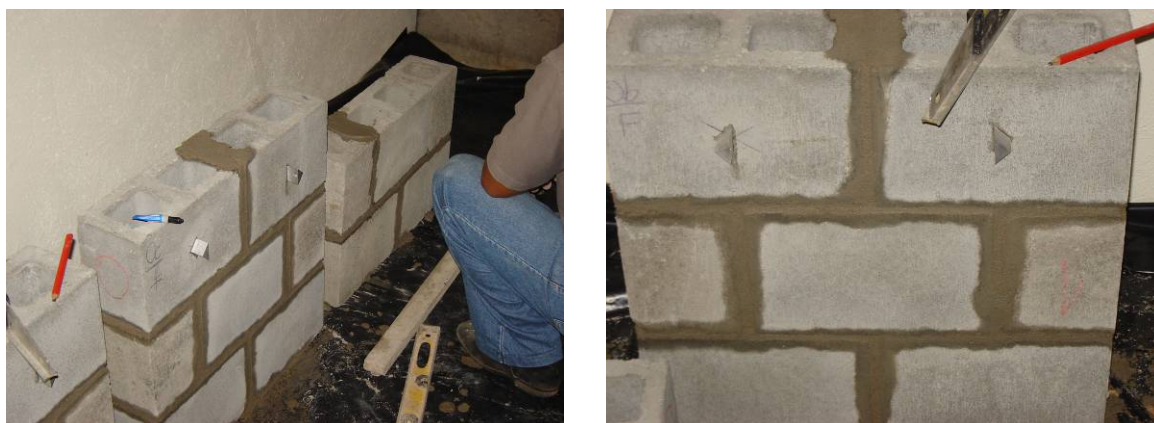
Figura 9.13 – Execução das miniparedes de retração.
