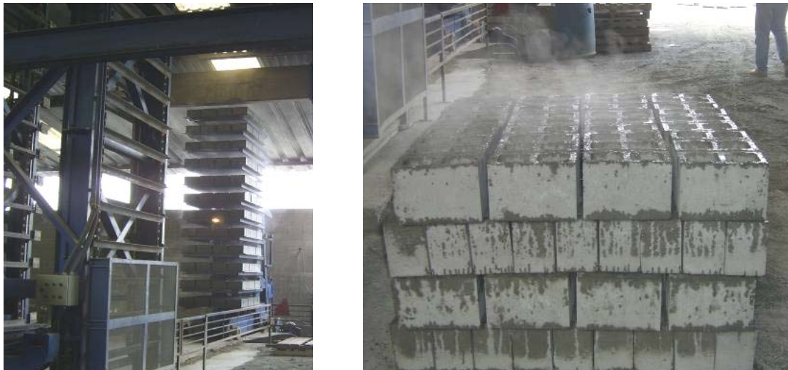
Figura 7.11 – Retirada dos blocos da câmara de cura térmica.
