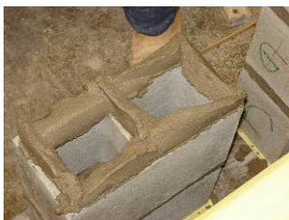
a) aplicação da segunda junta de argamassa
