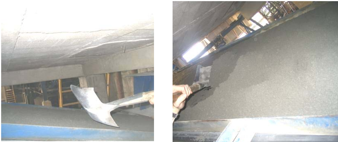
Figura 6.6 – Retirada das amostras de concreto para a produção dos corpos-de-prova.
