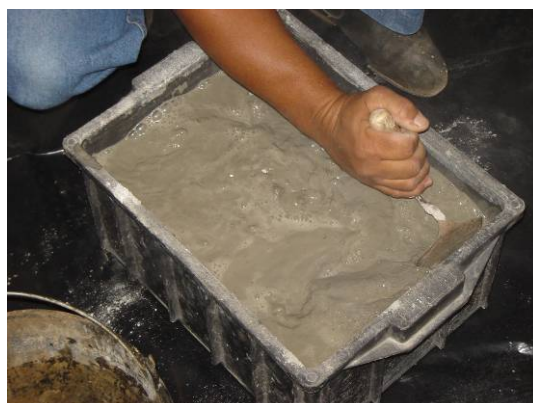
Figura 9.12 – Mistura manual da argamassa.
