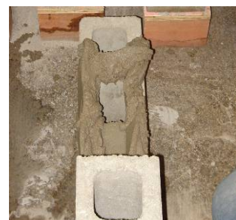
c) disposição dos cordões longitudinais e transversais de argamassa
