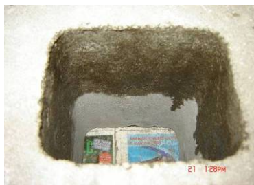
d) vista interna da parede do bloco impermeabilizada
