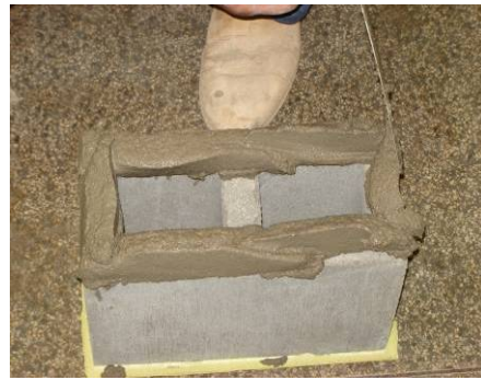
b) disposição dos cordões de argamassa
