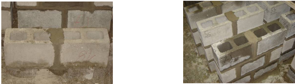
Figura 38 – Execução da última fiada.
