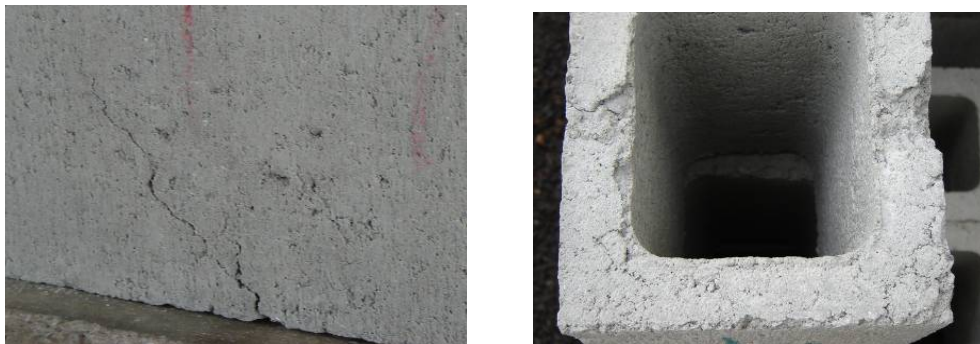
Figura 7.30 – Fissuras e cantos quebrados em algumas unidades do traço B8,0-RMB-33% ocasionadas pela falta de coesão e pela umidade excessiva da mistura.
