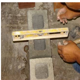
a) nivelamento dos blocos de base da miniparede
