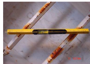
f) nivelamento dos suportes
