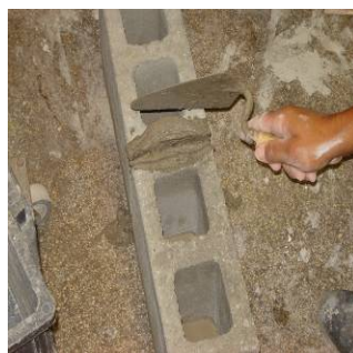
b) execução da junta vertical de argamassa
