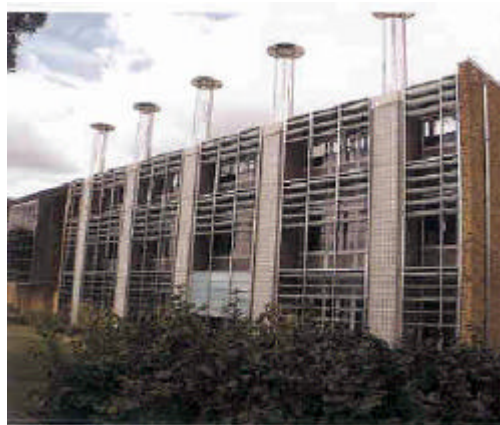
Figura 3.1 – Primeiro edifício no Reino Unido a utilizar concreto usinado produzido com agregados reciclados (COLLINS, 2000 apud LEVY; HELENE, 2002).
