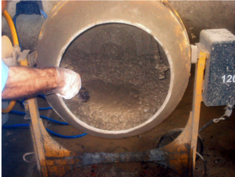
Figura 5.13 – Verificação do teor de argamassa.
