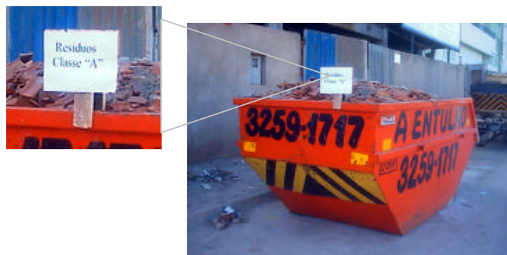
Figura 5.2 – Coleta seletiva de RCD “Classe A” no canteiro de obra.
