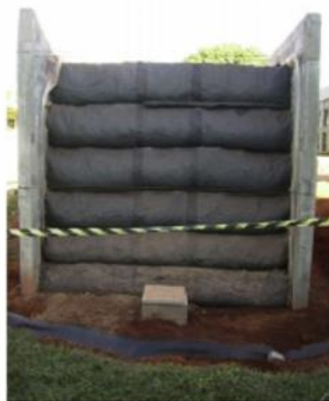
c) Face do muro após a construção
