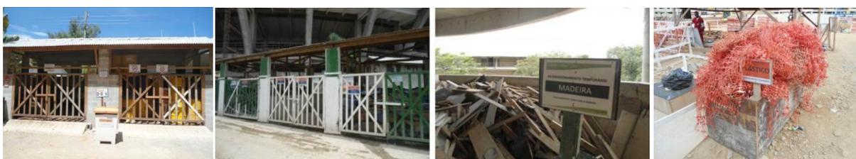
**Figura 31** - Baias de separação e pontos de armazenamento temporário dos materiais.
