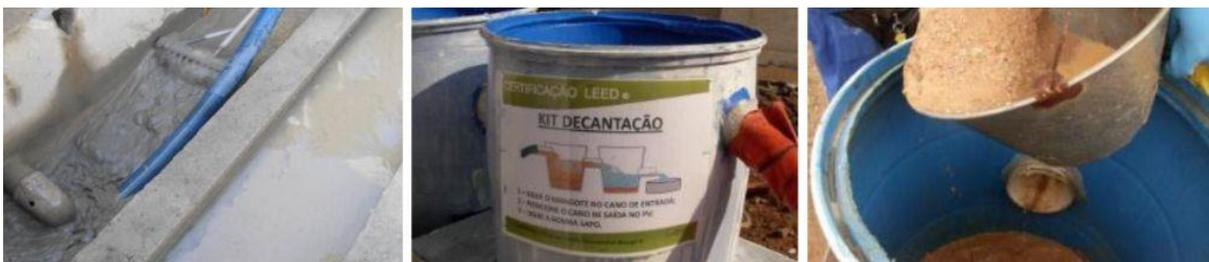
**Figura 28** - Decantadores móveis para controle de sedimentos na obra do Maracanã.
