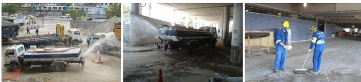
**Figura 34** - Varrição e aspersão de água por caminhões pipa para controle de poeira.
