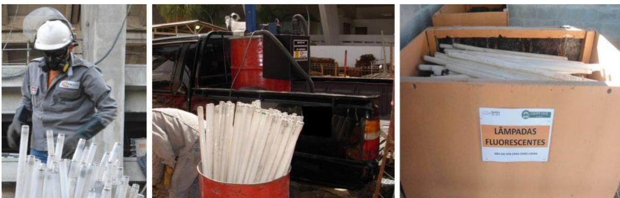
**Figura 32** - Papa lâmpadas e das lâmpadas recicladas no canteiro de obra do Maracanã.
