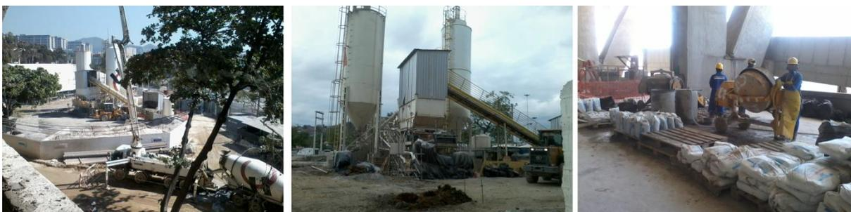
**Figura 40** - Central de concreto e produção de argamassa na área de trabalho.
