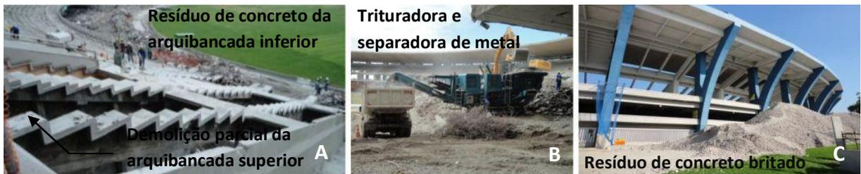
**Figura 15** - Demolição das arquibancadas e cobertura, e britagem do concreto.
