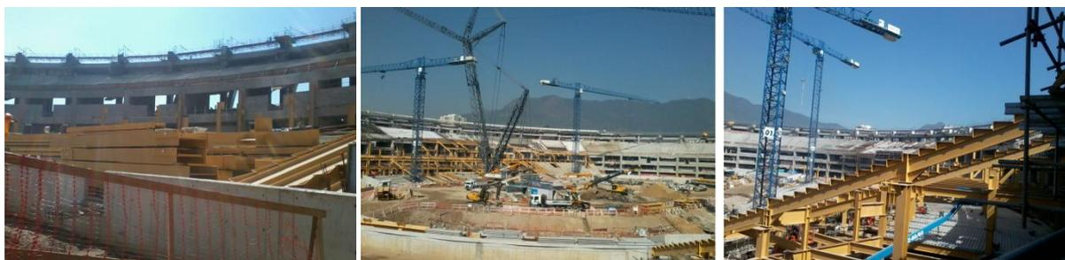
**Figura 38** - Estrutura pré-moldada e montagem das arquibancadas.
