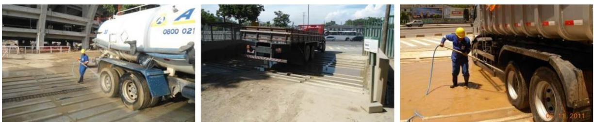
**Figura 25** - Imagens do lava-rodas e do processo de lavagem das rodas dos caminhões.
