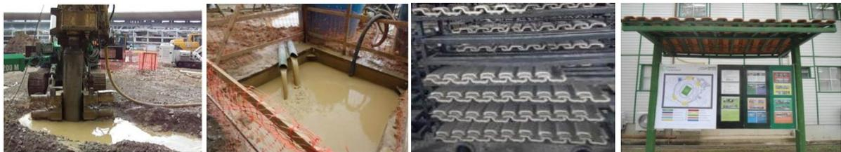
**Figura 24** - Imagens da perfuração de estacas e das telhas e tijolos resultantes da lama.
