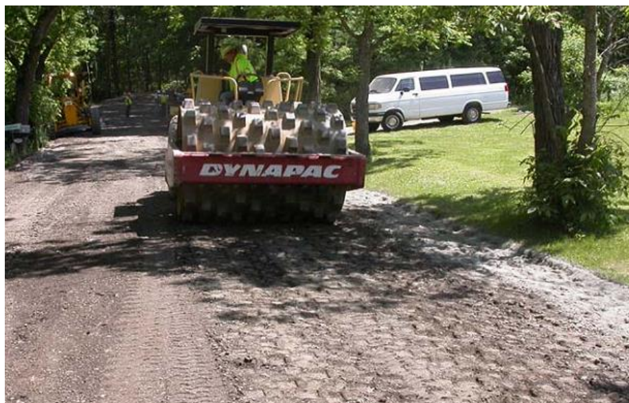
Figura 2.9 - Compactação de base reciclada (MORIAN, 2012)
