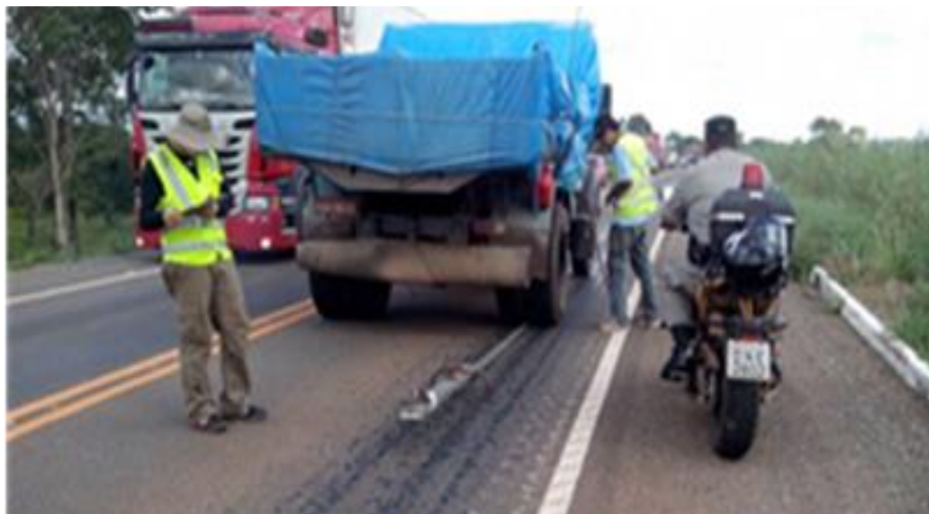
Figura 3.10 – Ensaio de Viga Benkelman
