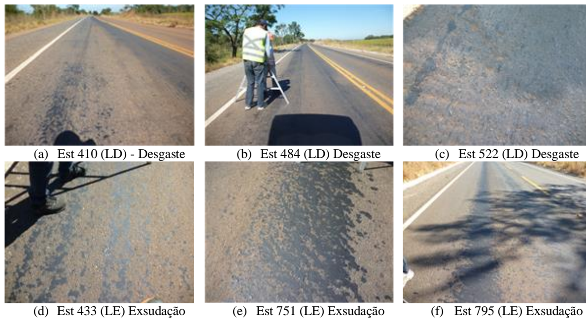
Figura 4.2 - Aspectos da superfície do pavimento de algumas estacas avaliadas para obtenção do IGG na GO-156
