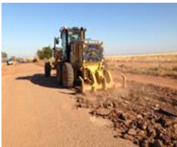
(a) Escarificação com Motoniveladora
