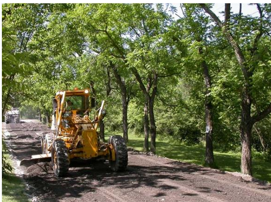
Figura 2.8 - Modelagem da mistura com niveladora (MORIAN, 2012).
