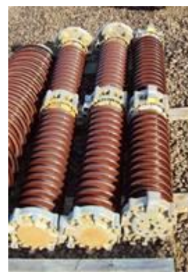
(b) Isoladores substituídos em Foz do Iguaçu
