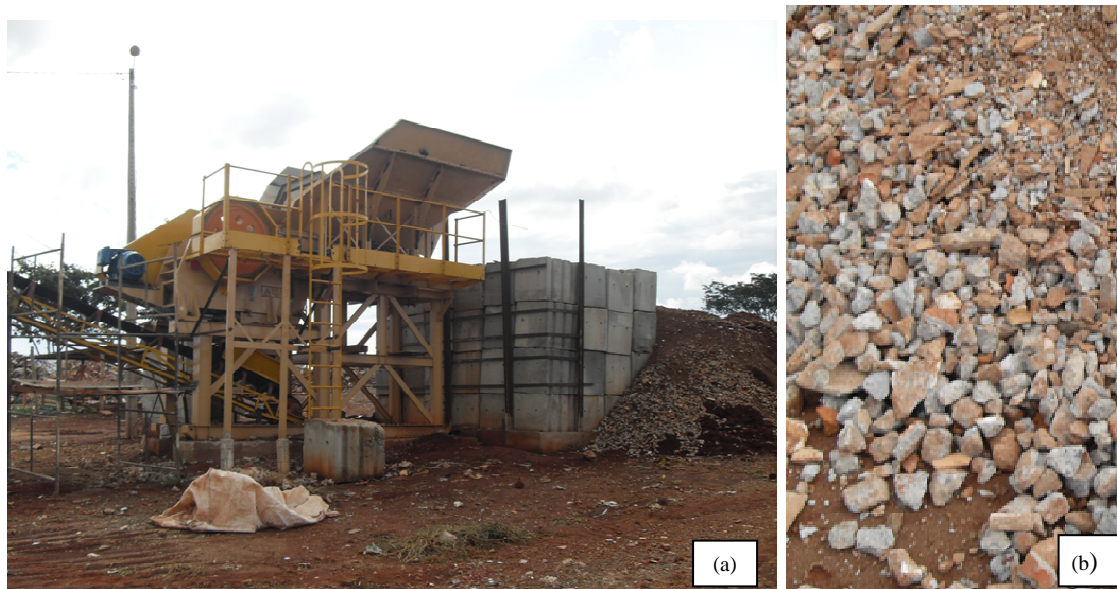
Figura 2.8 – Primeira usina de reciclagem de resíduos da construção e demolição instalada na RMG. (a) Britador; (b) Material para seleção granulométrica.
