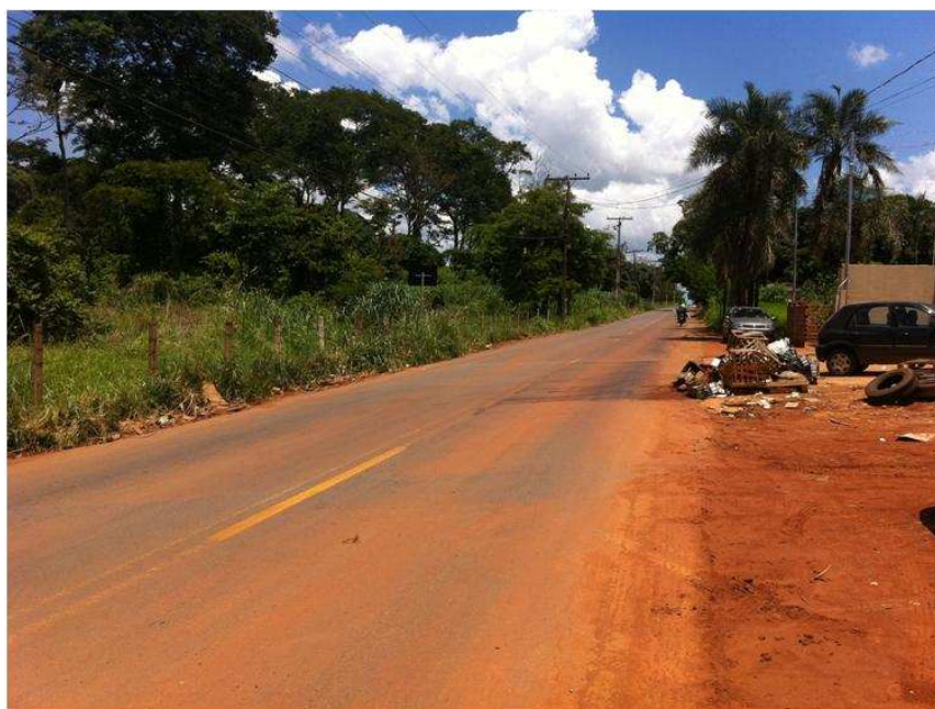
Figura 4.1 – Calçadas sem revestimento e sem edificações no Trecho 1.
