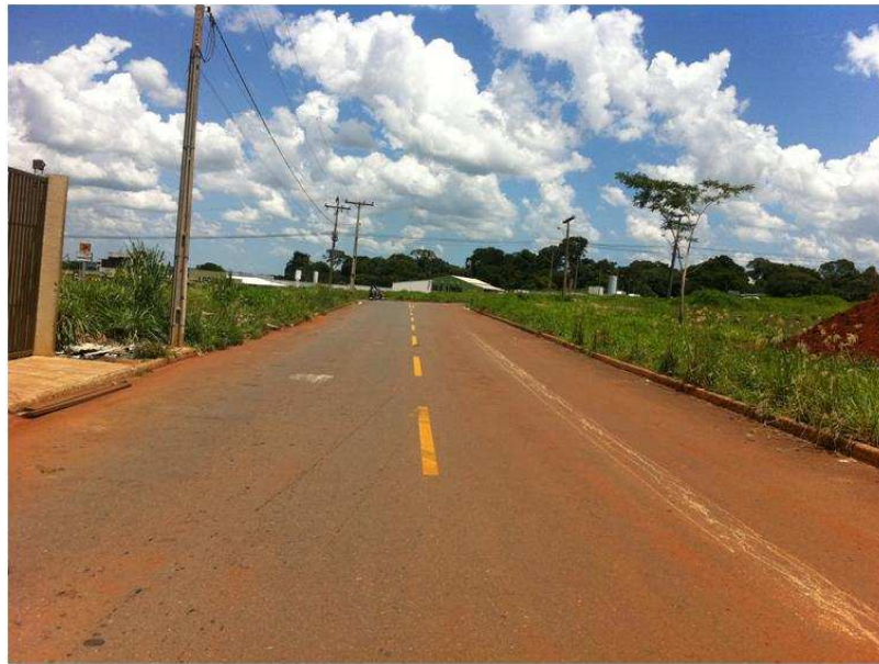
Figura 4.31 – Calçadas sem revestimento e sem edificações no Trecho 1.
