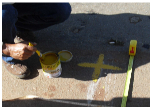
Figura 3.2 – Demarcação das estacas sobre o revestimento.
