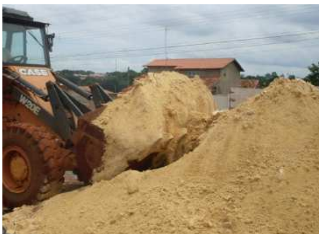
Figura 2.5 – Fosfogesso sendo homogeneizado na pista. (Modificado de METEGO, 2010).
