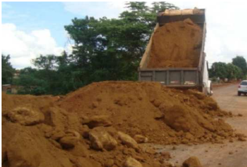
Figura 2.2 – Foto de obra com execução de subtrecho em cascalho laterítico (CUNHA, 2010).
