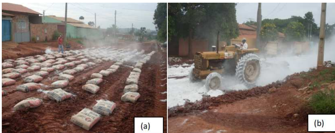
Figura 2.6 – Foto da execução de uma pista com solo-cal: (a) Disposição dos sacos de cal sobre o solo argiloso; (b) Homogeneização do solo com a cal (Modificado de CUNHA, 2011).
