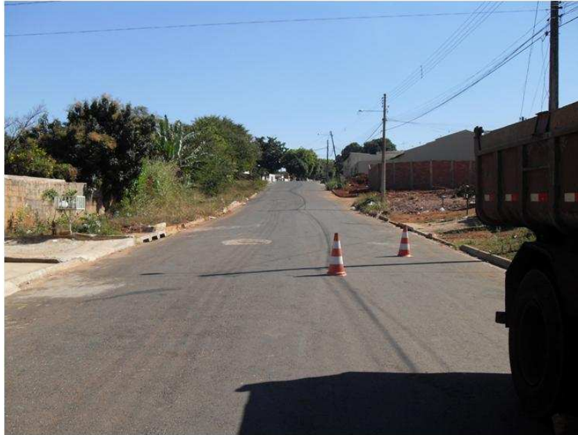
Figura 4.15 – Calçadas sem revestimento e sem edificações no Trecho 2
