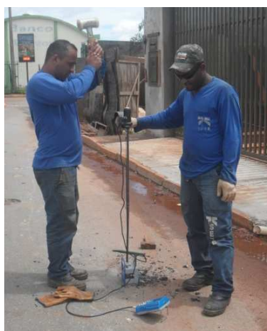
Figura 3.6 – Ensaio com o Equipamento PANDA.
